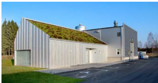
Reningsanläggningen i Jönköping
