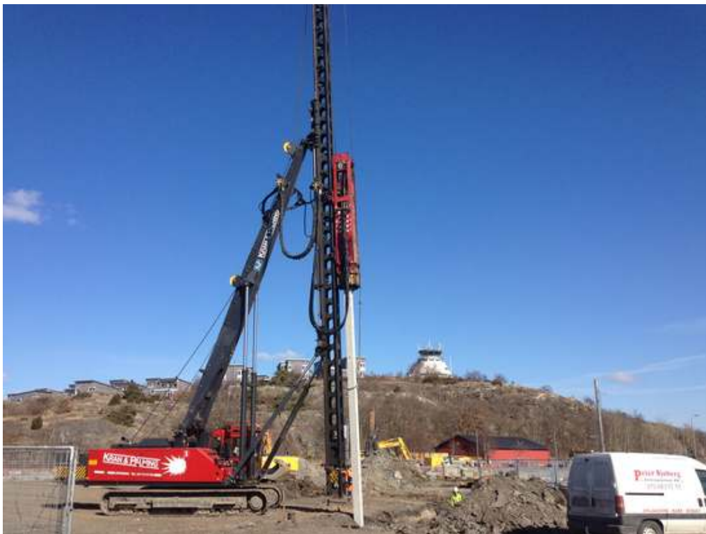
Under påsken 2013 inleddes pålningsarbetet för kvarter K.
