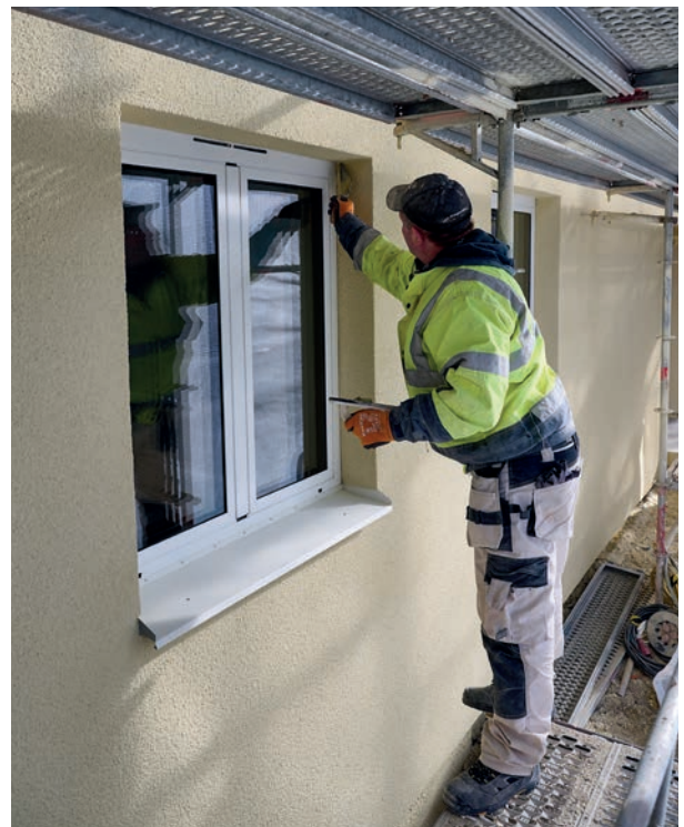
Porfyrvägen. Fasad- och fönsterrenovering.
