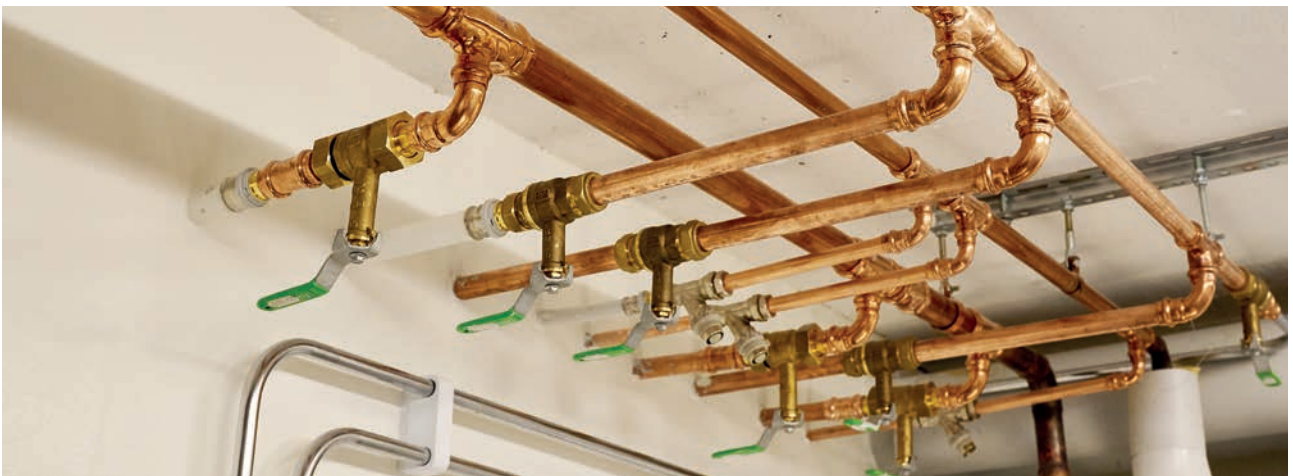
Skrinvägen. Utbyte av äldre förråd och tvätttrum i källarutrymmen. Hållbara uppvärmningslösningar.
