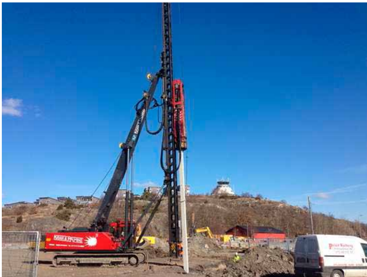
Under påsken 2013 inleddes pålningsarbetet för kvarter K.
